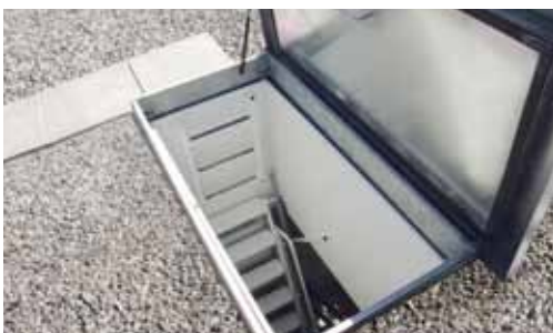
Flachdachtreppe – bei Bedarf Ausstiegshilfe in Lukenkasten
