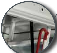
Treppenstufen nicht direkt am Unterdeckel anliegend, dadurch letzte Treppenstufe ca. 20 cm im Lukenkasten
