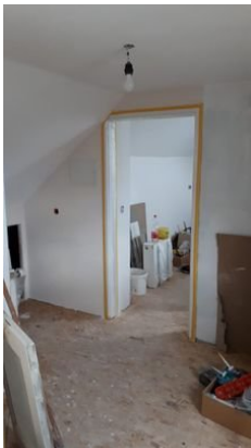
Dachgeschossausbau ist fertig
