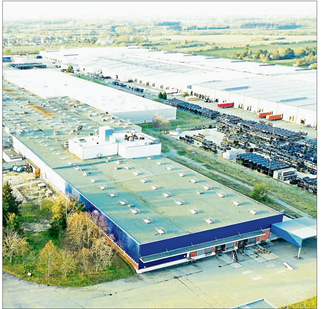
Die Wirth-Gruppe und pfenning Gruppe unterstützen Lebensmittellogistik durch flexible Lagerkapazität im künftigen Gewerbepark auf dem ehemaligen Goodyear-Gelände. BILD: PFENNING
