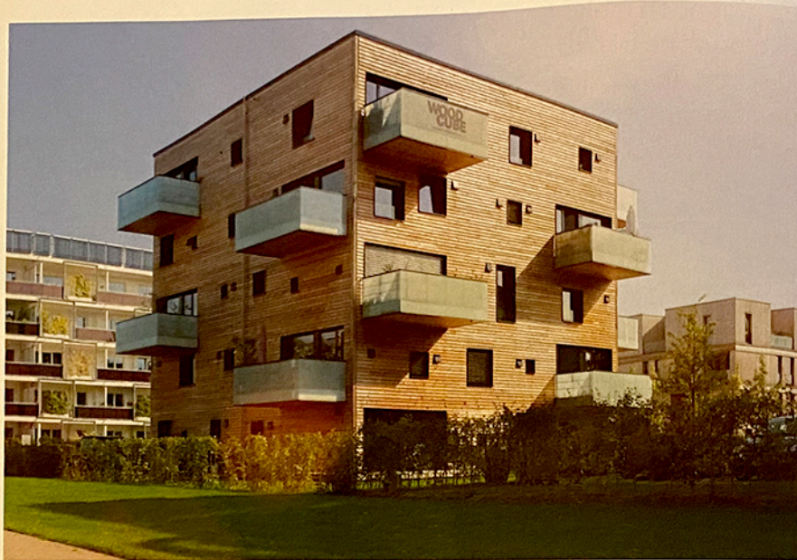
Fünf Etagen aus Massivholz, komplett schadstofffrei und CO 2 -neutral: Der „Woodcube“ von Matthias Korffs Unternehmen DeepGreen Development entstand 2013 im Rahmen der Internationalen Bauausstellung in Wilhelmsburg
