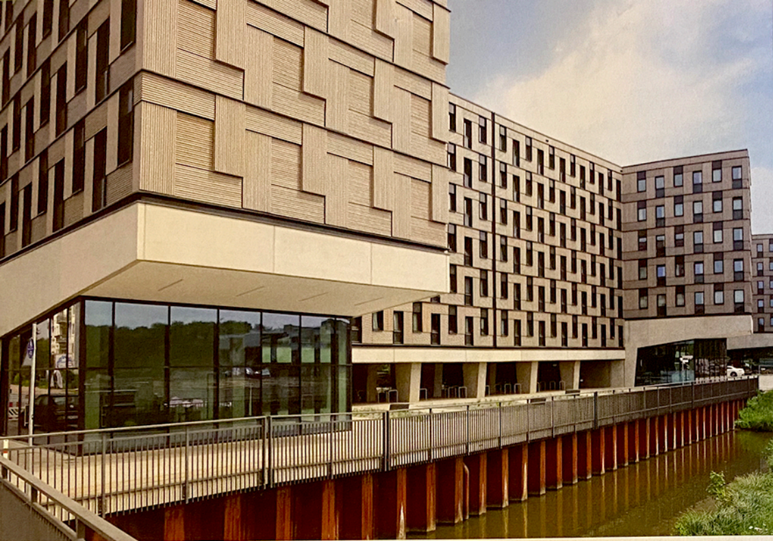
Großbauten aus Holz sind technisch kein Problem: Die sechs Etagen des Studentenwohnheims „Woodie“ in Wilhelmsburg bestehen aus vorgefertigten Holzcontainern, die auf eine Stahlbeton-Sockelkonstruktion im Erdgeschoss aufgesetzt wurden
