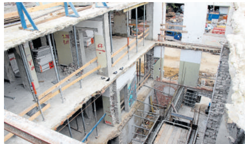
Durch die offenen Wände schweift der Blick bis in den Keller und offenbart die massiven Mauern der früheren Kasernenbauten.
