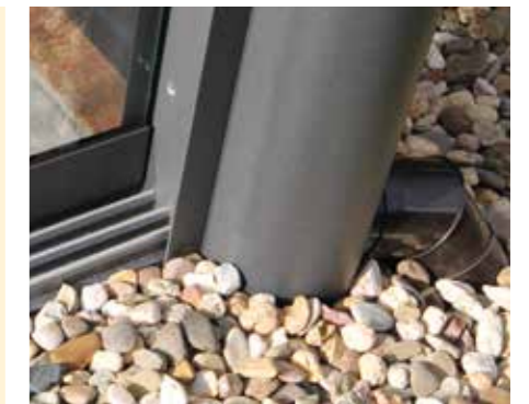
PASSGENAUIGKEIT | Schiebeanlagen von Dypmann fügen sich perfekt ein, der Regenabfluss ist in die Stütze integriert.
