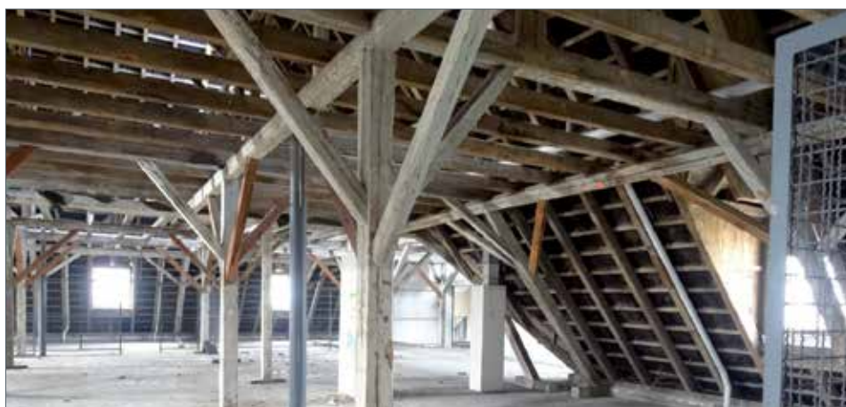
Das Holz der Kasernen-Dachstühle – rund 100 Kubikmeter – wird vor Ort in einem mobilen Sägewerk zu neuen Baumaterialien umgearbeitet
