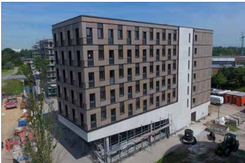
Studentenwohnheim „Woodie“ aus Wohncontainern sechs Etagen hoch auf dem Beton-Basisgeschoss gestapelt. Dazwischen das Treppenhaus aus Beton
