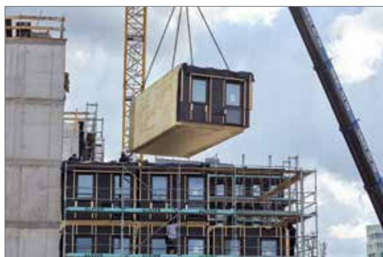
Sechs Module wurden jeweils übereinander gestapelt. Zuvor wurden die 20 qm großen Container bezugsfähig ausgestattet
