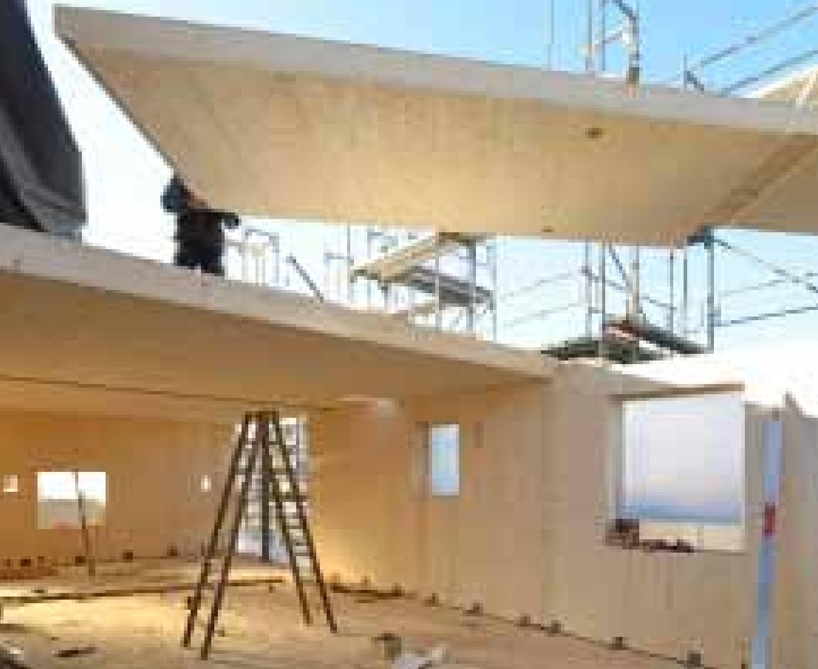
Um den Aufzugs- und Treppenhausschacht aus Stahlbeton werden die fünf Stockwerke aufgerichtet
