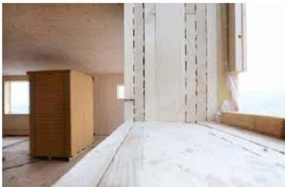
garantieren und „atmende Wände ohne Kondensat und Schimmel“ garantieren. Die Holzdübel werden im sehr trockenen Zustand eingepresst, quellen deshalb im Verbund auf und verbinden sich beim Quellvorgang kraftschlüssig und unlösbar in der Wand, „fest wie verwachsene Äste“, betont Unternehmer Thoma.
