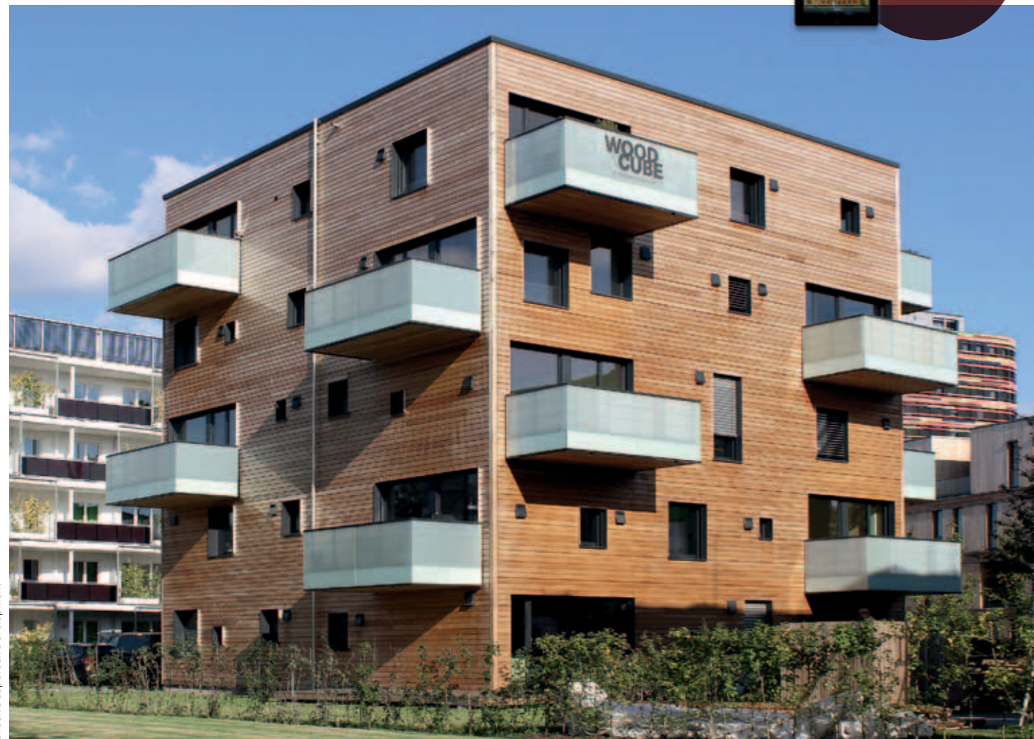
Bilder: DeepGreen Development Der Hamburger Woodcube, erbaut im Massivholz-Bauweise, erhielt beim Dt. Nachhaltigkeitspreis 2013 den „Top 3 Sonderpreis Nachhaltiges Bauen“.
