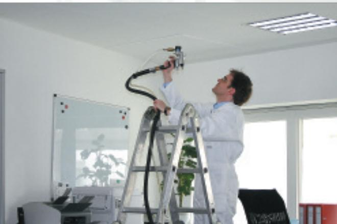
Die Applikation des Materials erfolgt im bewährten HVLP-Sprühverfahren und ist ohne Betriebsunterbrechungen möglich. Das verwendete Material ist transparent, geruchsneutral und völlig ungefährlich für Mensch und Tier.
