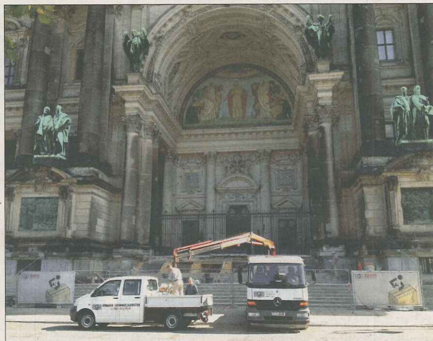
▲ Sanierungsarbeiten an der Eingangstreppe des Berliner Doms. Foto: Gebauer, nh
