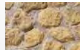
PIEDRA DE ADOBE
